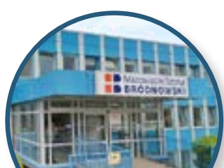
Mazowiecki Szpital Bródnowski w Warszawie Sp. z o.o.
