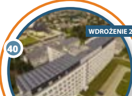
40 Wdrożenie 2021 Szpital Specjalistyczny im. H. Klimontowicza w Gorlicach
